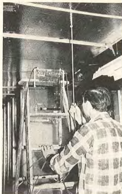
Fig. 2. I forbindelse med indreguleringen måles luftmængder i kanaler altid med pitotrør og skrårørsmanometer.
